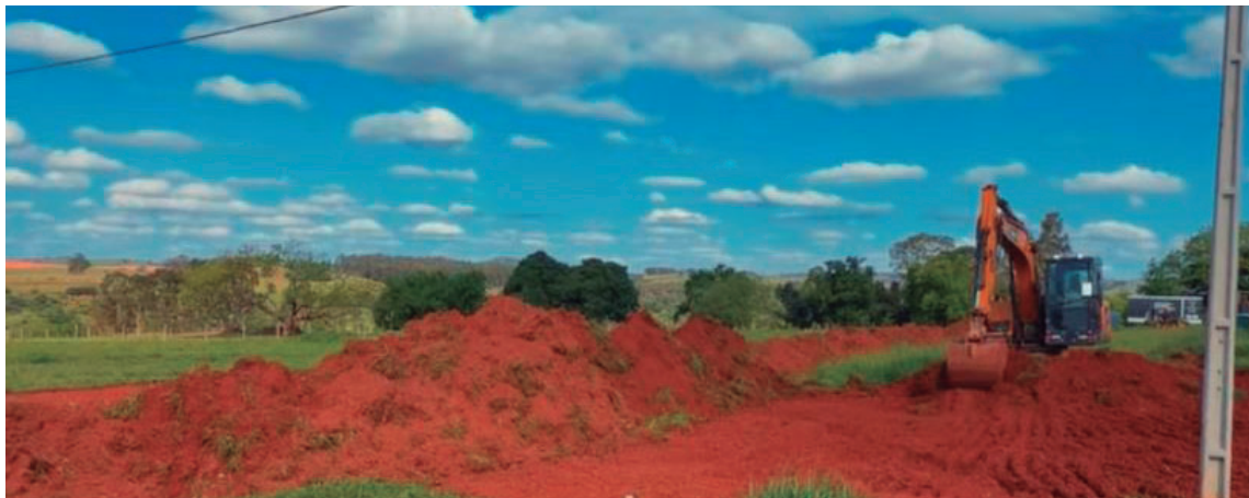
Obras para construção de 31 novas moradias da CDHU já tiveram início em Oscar Bressane, conforme publicação do prefeito
