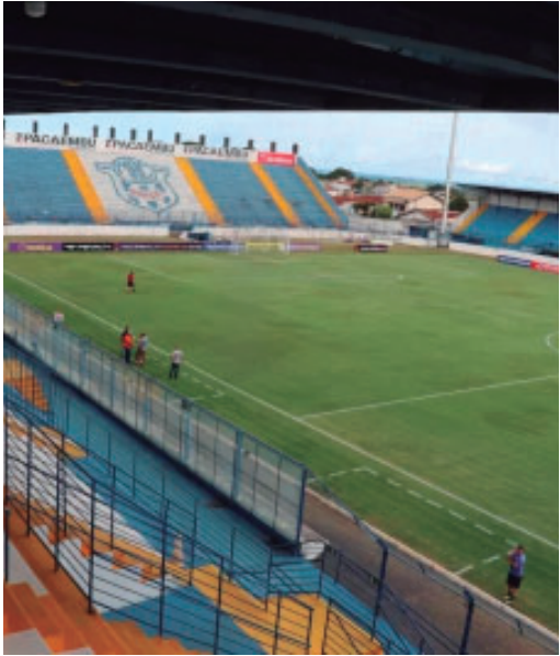
Contrato garante reforma do estádio
