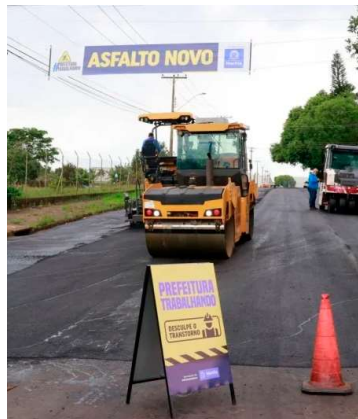
Ação integra o programa Asfalto Novo
